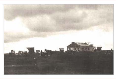
En el período fundacional de la ciudad de La Plata se construyó una usina en el actual Parque Saavedra, con dos calderas, dos máquinas de vapor, y dos bombas para elevar el agua a un tanque metálico ubicado sobre una estructura metálica. La extracción desde las perforaciones se efectuaba mediante aire comprimido. La zona abastecida comprendía las calles 1 a 13 y 44 a 60. La previsión era para 30.000 habitantes.
